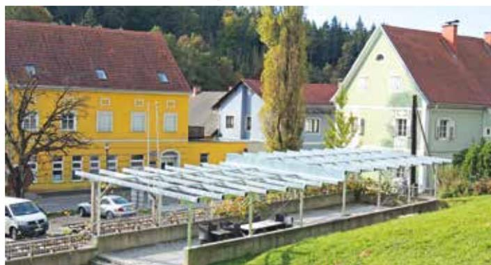
Beim Rathaus bzw. beim Rathauspark wird derzeit eine 18 kWp-Anlage errichtet. Damit verbunden ist auch ein entsprechender Stromspeicher. Ebenfalls noch in diesem Jahr wird beim Wohnhaus Unterer Markt 30/32 ebenfalls eine 18 kWp-Anlage mit Speicher errichtet.
