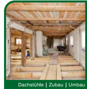
Dachstühle | Zubau | Umbau
